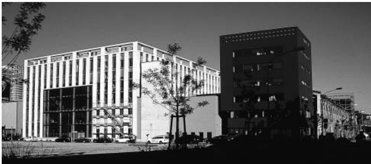
Blick auf den Malsaal und Schiffbau 10
